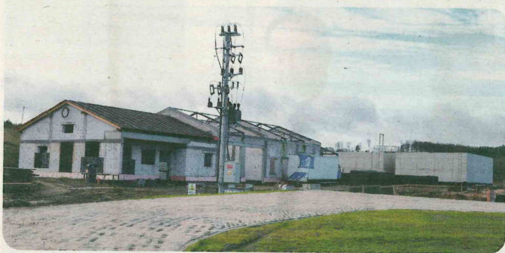
☞ 29 kwietnia ma zostać rozstrzygnięty przetarg na dokończenie budowy oczyszczalni ścieków w Piekle Dolnym
