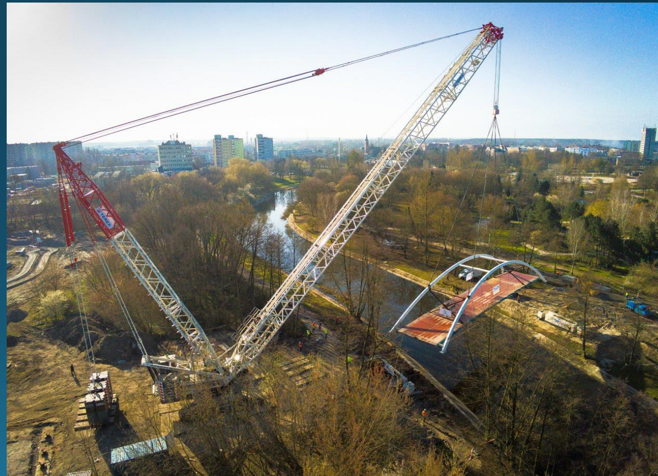
Montaż kładki pieszo-rowerowej
