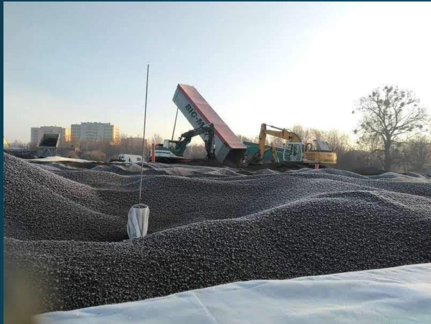
Budowa skatoparku i toru rowowego
