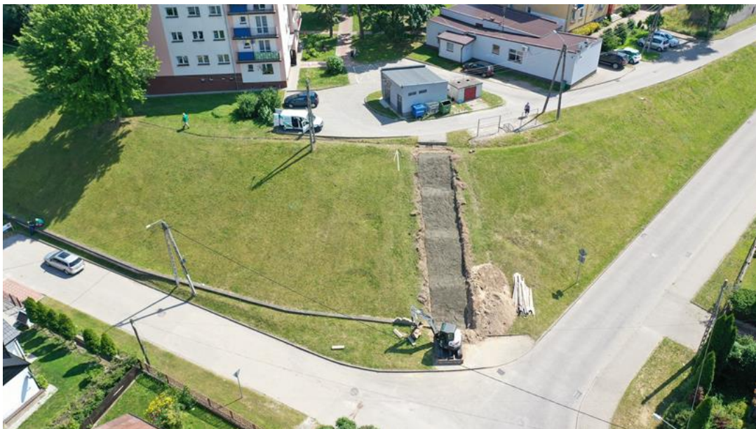
Na zdj. skarpa przy os. Broniewskiego w czasie remontu schodów
