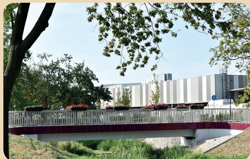
- budowa dwóch kładek pieszo-rowerowych (nawierzchnia z drewna egzotycznego, poręcze ze stali nierdzewnej)
