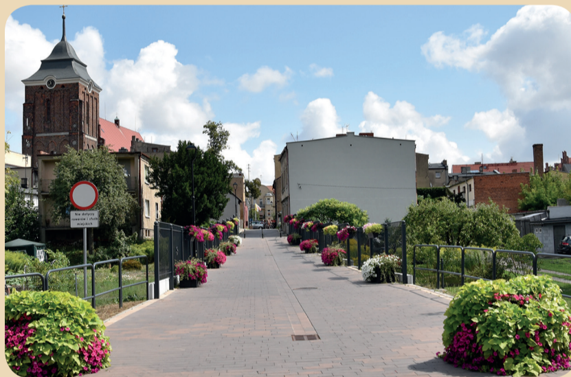
- przebudowa ul. Rzecznej (na długości ok. 115 m, 3 stylizowane lampy z oprawami typu LED)
