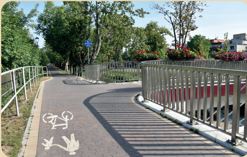
- budowa ścieżki pieszo-rowerowej wzdłuż rzeki Wrześnicy (długość ok. 570 m, 16 stylizowanych lamp z oprawami typu LED)
