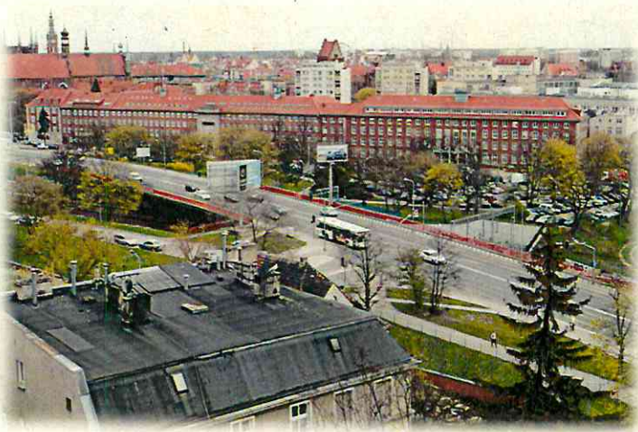
Fot. 2 Zdjęcie przed rozpoczęciem realizacji inwestycji
