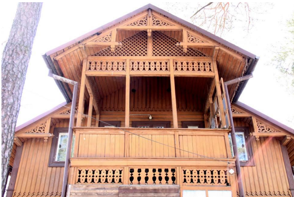
Widok detali w obrębie werand przed modernizacją
